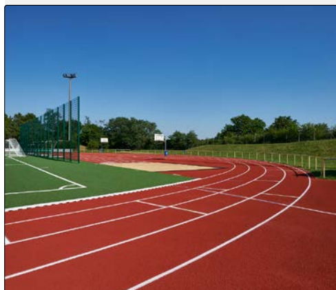
Auch der Kunststoffbelag der Laufbahn wurde erneuert.
